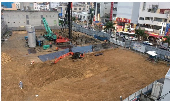
國際通飯店 - 防止紅土流出工程 現況照片
