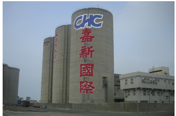
台中港水泥儲槽
