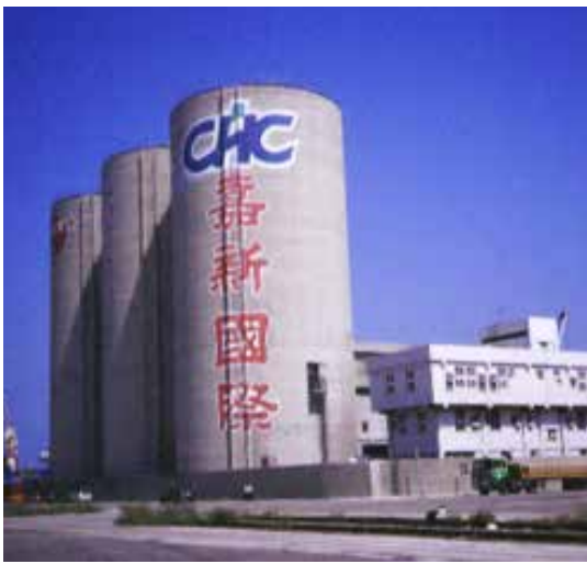
△ 台中港水泥儲槽
