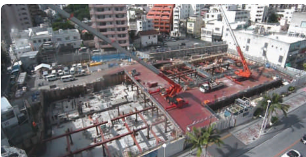
• 國際通飯店 現場建造實景照
