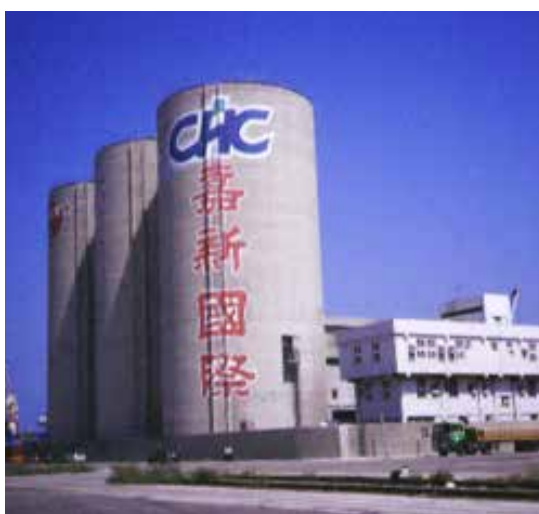
△ 台中港水泥儲槽
